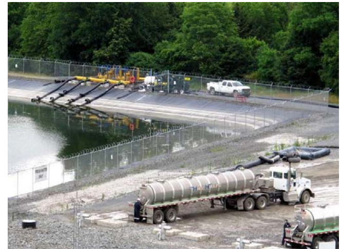
Zentral angelegtes Becken für Frischwasser in Pennsylvania
